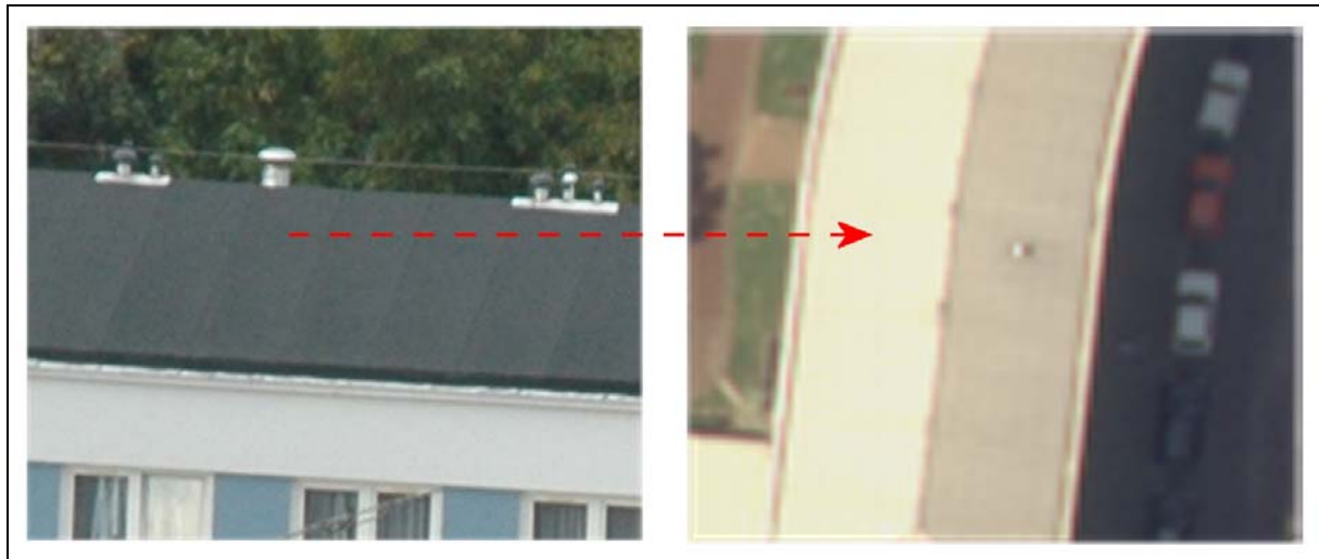
Figure 6-29 Toit métallique dans les images aériennes qui a été refait depuis la prise de vue.
