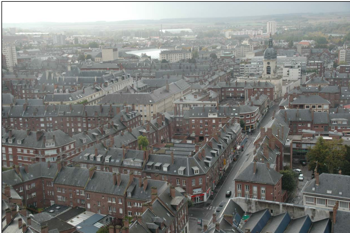
Figure 6-11 Vue globale du centre-ville d'Amiens (permettant de voir les bâtiments de la Figure 6-1 b) ).
