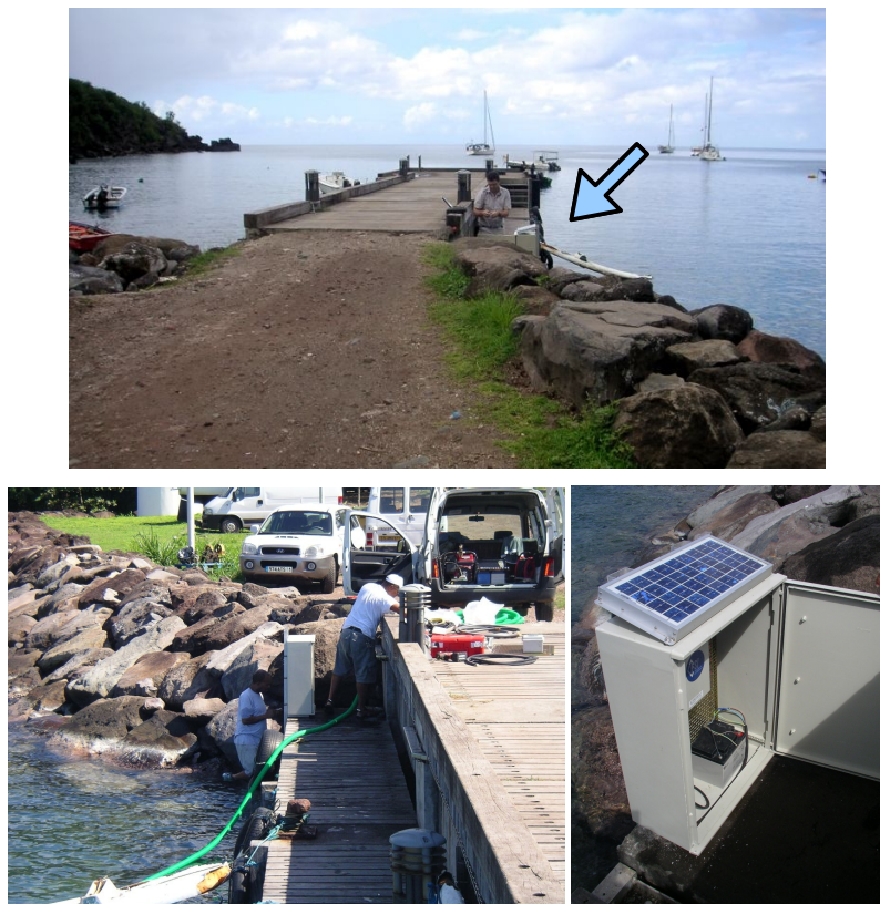
Figure 11. Site Anse à la Barque : vue générale du ponton, position du coffret, coffret d'acquisition
